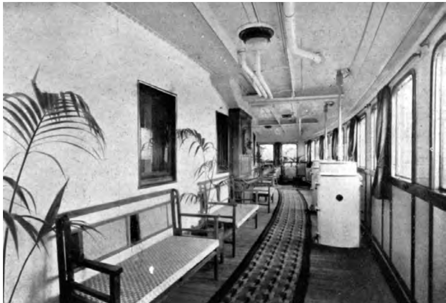
Fig. 8 - Anni '30: veranda con controller del posto di comando di piancia dello Scilla .
